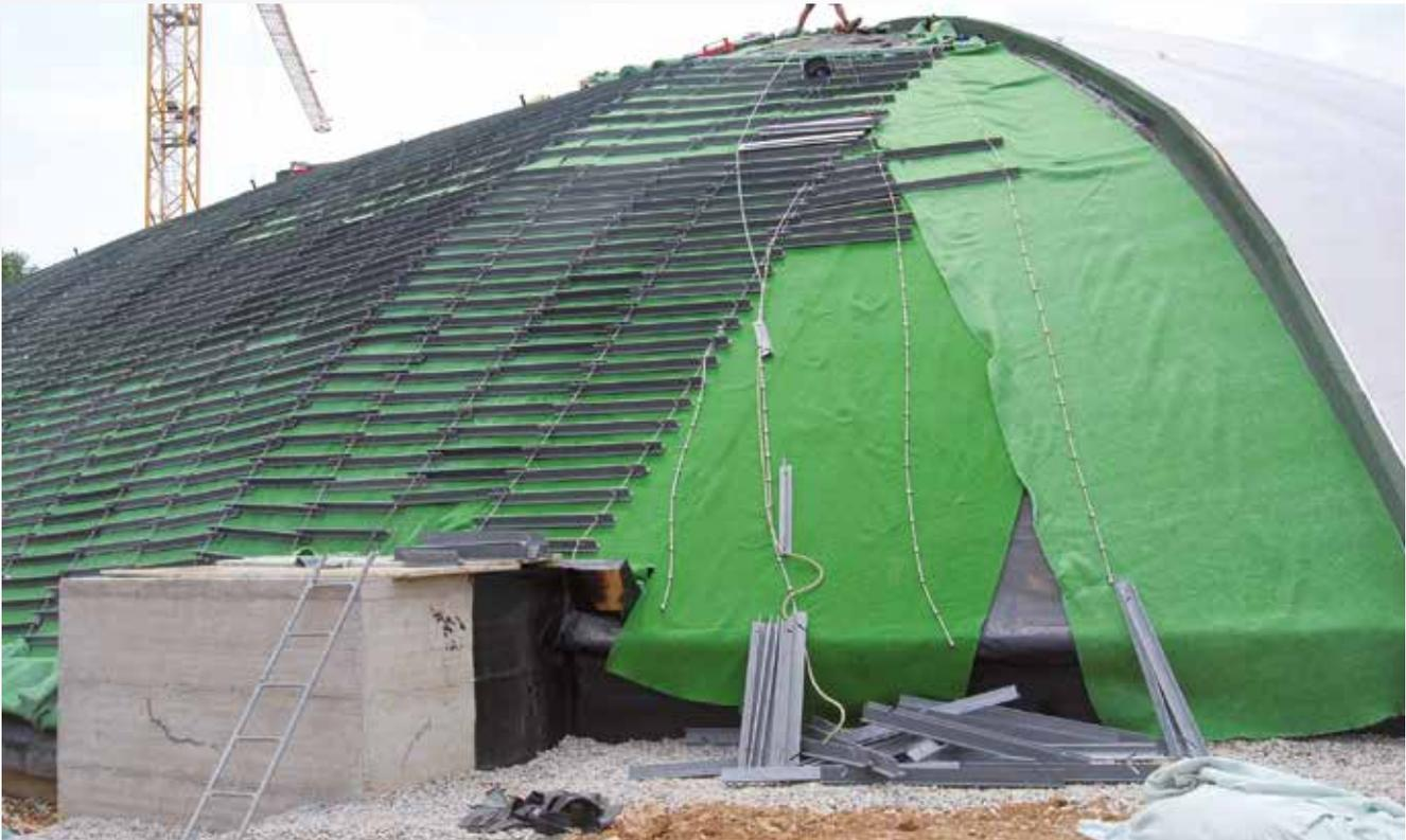
Bei Tonnendächern ermöglicht der Einsatz von Ketten und Bändern aus Edelstahl Rostfrei, die schubaufnehmenden Schwellen von oben abzuhängen und dadurch Dachdurchdringungen zu vermeiden.
