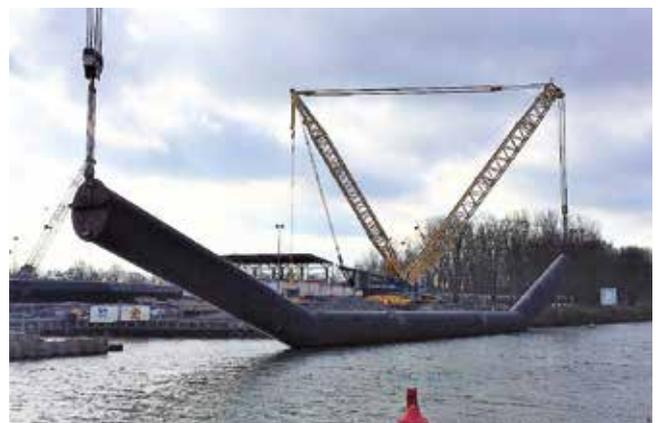
Eins der fünf 100 Meter langen Rohre des Ahse-Dückers vor dem Absenken in den Datteln-Hamm-Kanal
