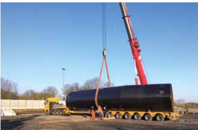
Die Rohre für den Ahse-Dücker mit einem Durchmesser von 3,60 Metern wurden per Schwertransport zur Baustelle transportiert.
