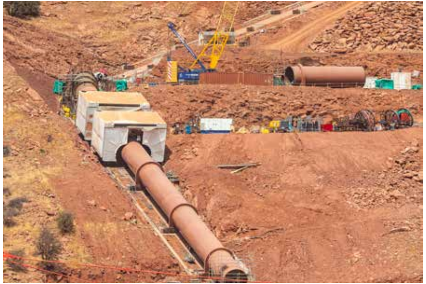
Montageabschnitt eines Krümmers für den mit Stahl ausgekleideten Triebwasserweg des Pumpspeicherwerks Abdelmoumen in Marokko
