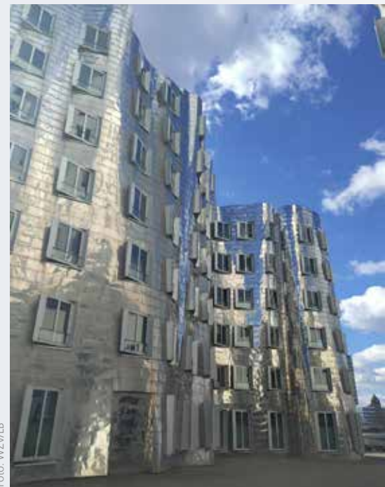
Der Neue Zollhof in Düsseldorf zeigt, wie fließende Formen und eine Gebäudehülle aus Edelstahl Frank Gehrys Architektur prägen.
