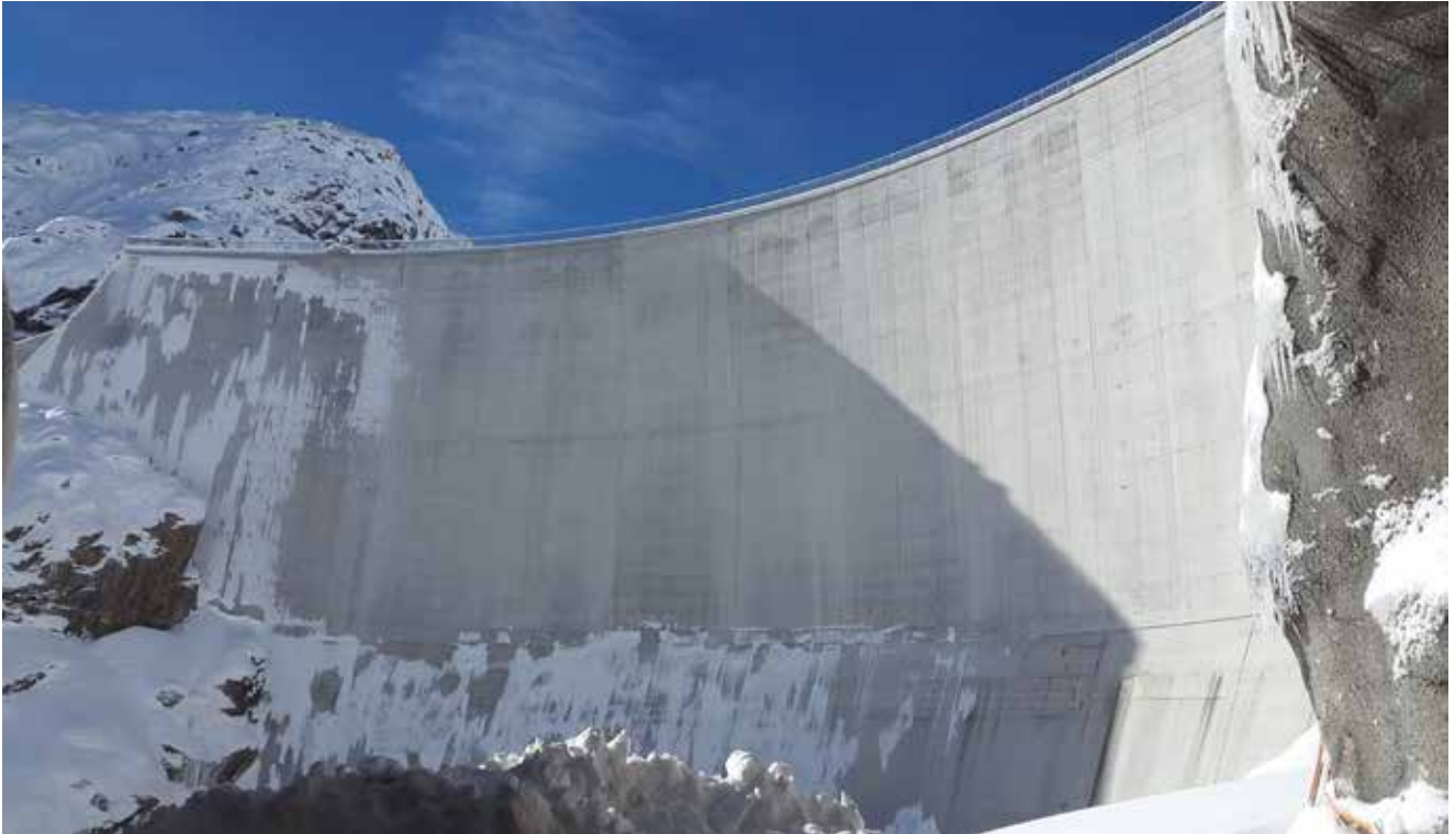
Der Damm des Emosson-Sees für das Pumpspeicherkraftwerk Nant de Drance in den Walliser Alpen, Schweiz
