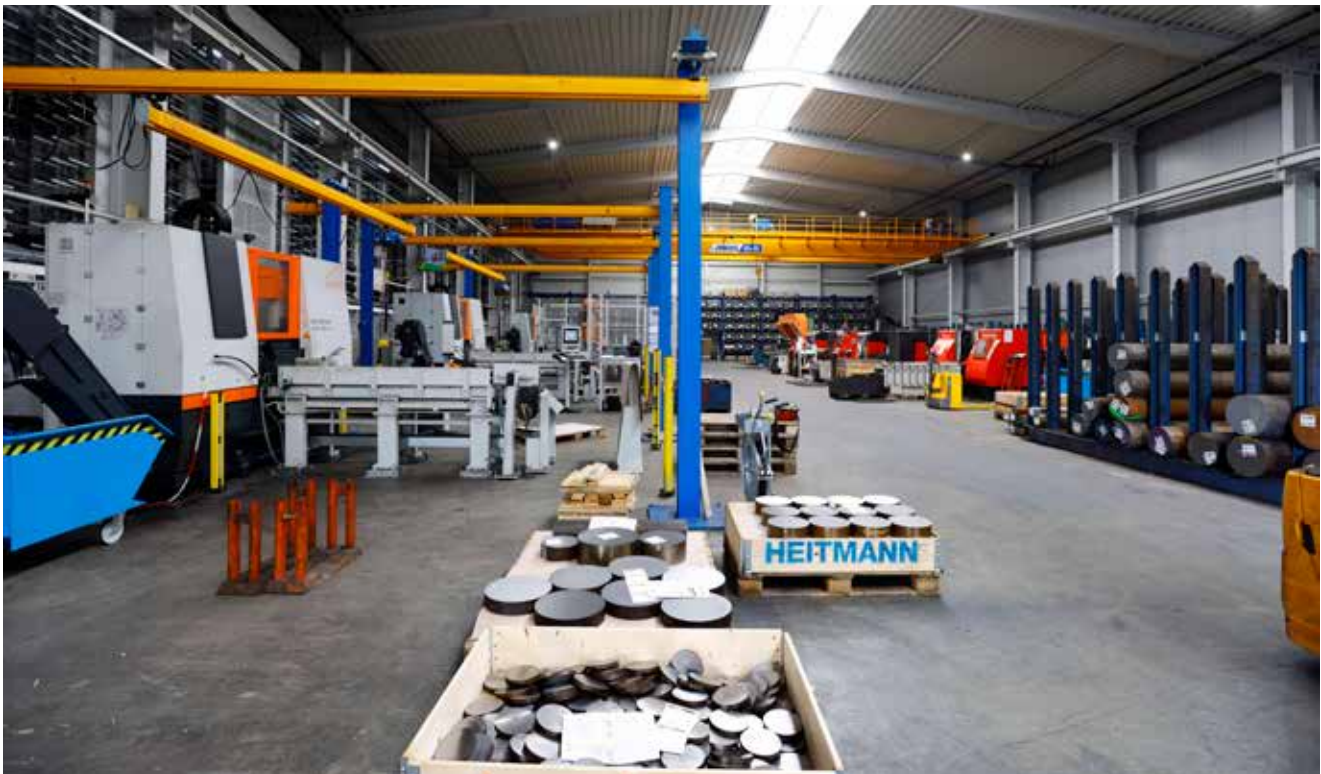
Herzstück der neuen Halle: ein Sägezentrum mit 784 Fächern für Längen bis 7 500 Millimeter beziehungsweise 1588 Fächern für die Einlagerung von bis zu 3 700 Millimeter langen Stäben.
