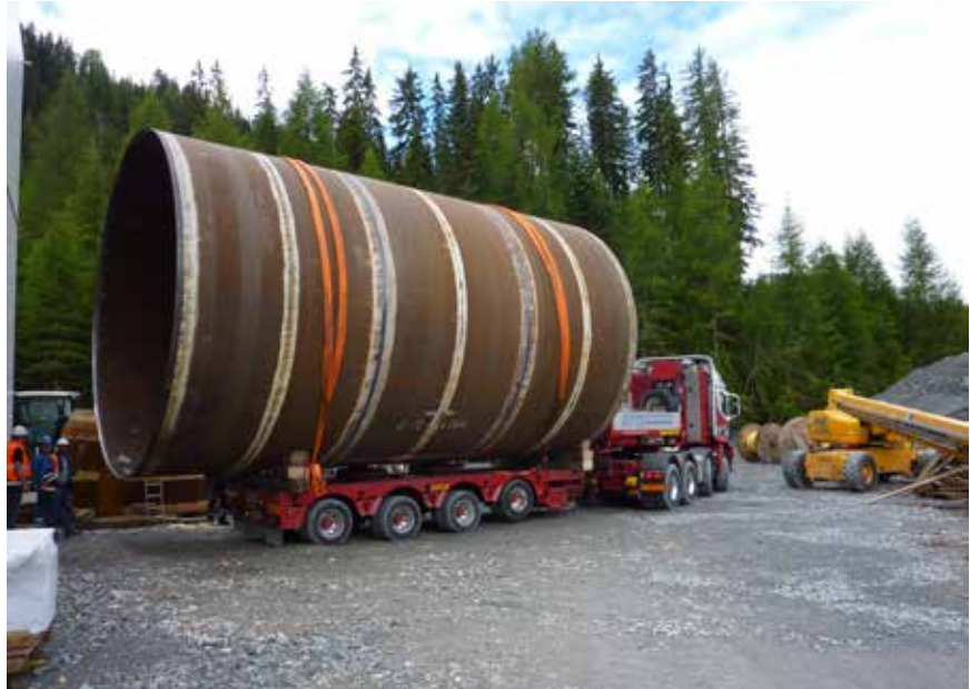
Transport der für das Kraftwerk Kaunertal im Tal gefertigten Sechs-Meter-Rohrsegmente zur Vorfertigung der benötigten zwölf Meter langen Segmente auf dem Berg
