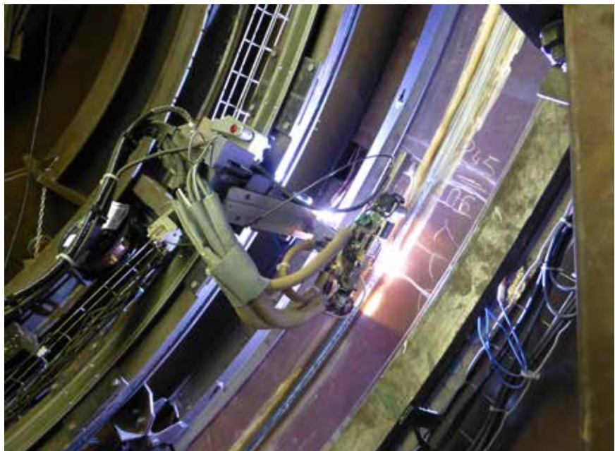
Die von ANDRITZ Hydro im Stollen des Kraftwerks Kaunertal eingesetzte WIG-Heißdraht-Schweißtechnik minimiert den Wasserstoffgehalt im Schweißgut und damit das Risiko von Rissbildung.
